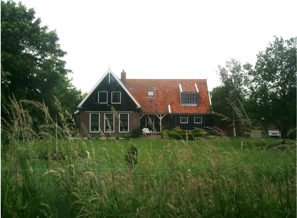
Landelijke architectuur: lage goot, geleding van bouwvolumes en eenduidige kapvormen.
