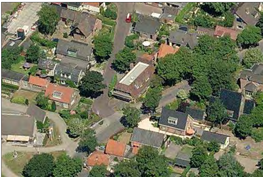
Figuur 1. Bestaande situatie in het plangebied
