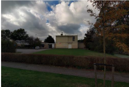
Bestaande bebouwing 'Overbrugging'.
