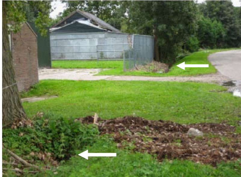
afwateringsgreppel tussen tuin en berm
