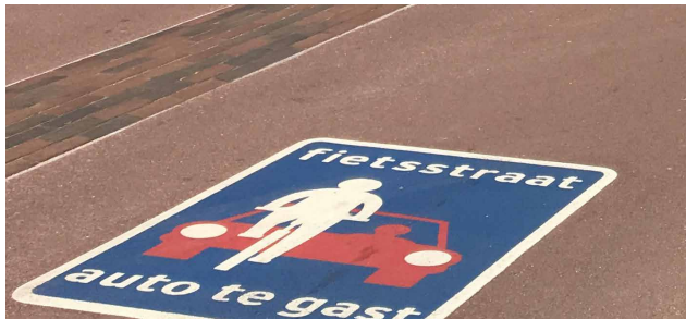
toegepaste verhardingen fietsstraat asfalt + gebakken klinkers
