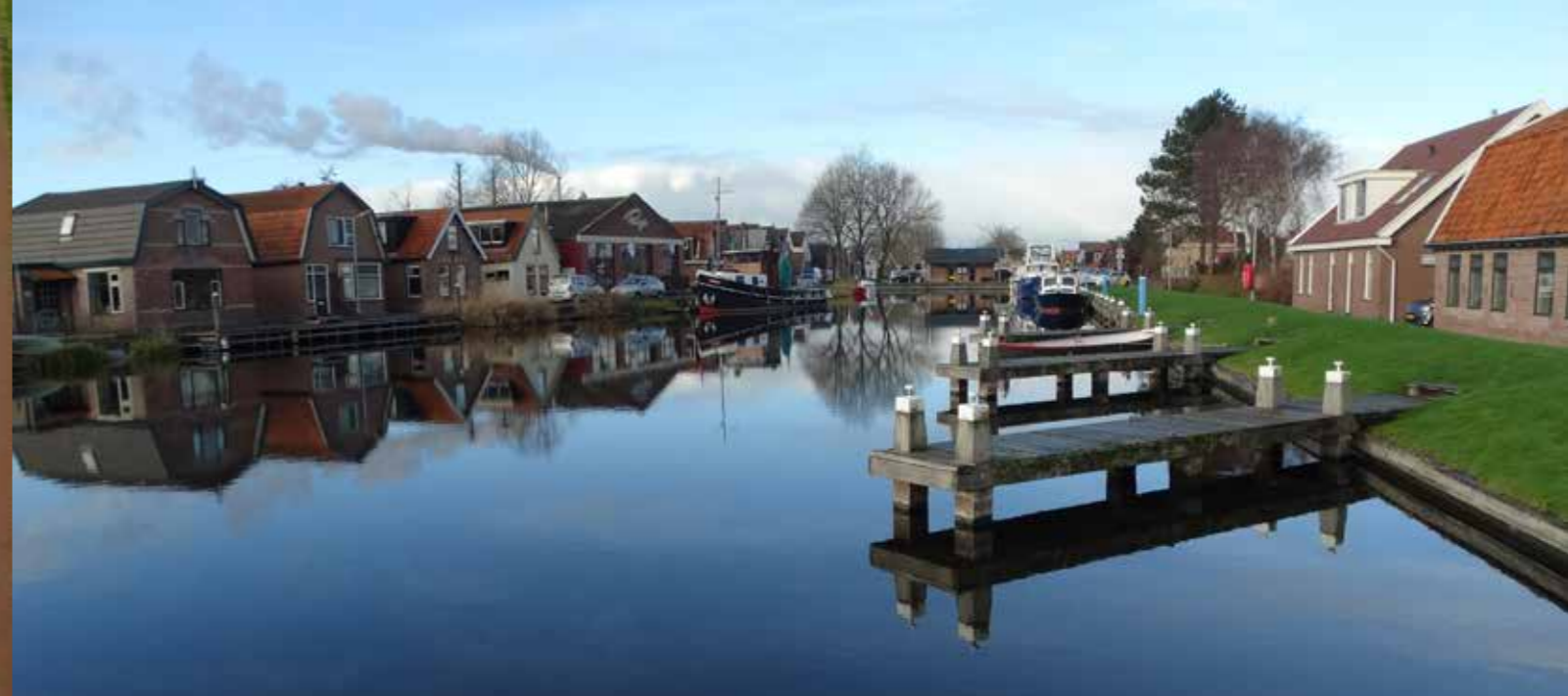
Passantenhaven Broek op Langedijk
