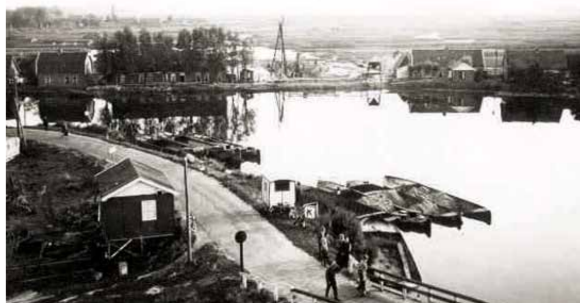
Historische beeld van de bouw van de sluis met rechts de monding van de passantenhaven
