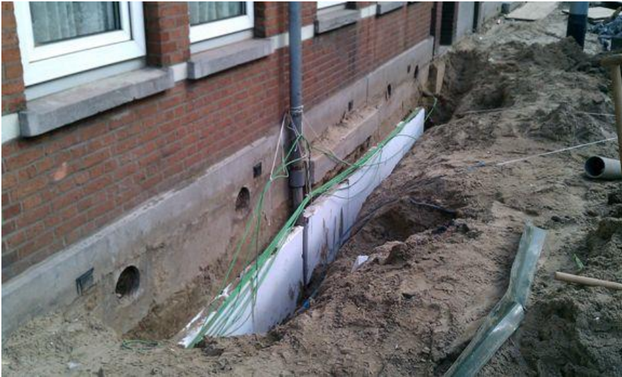
Figuur 7: Voorbeeld aanbrengen trillingsscherm
